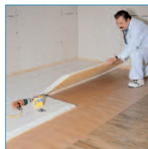
L'adesivo per massetti **Rigidur** deve essere applicato sul bordo battentato aperto verso l'alto in direzione della fuga trasversale.
